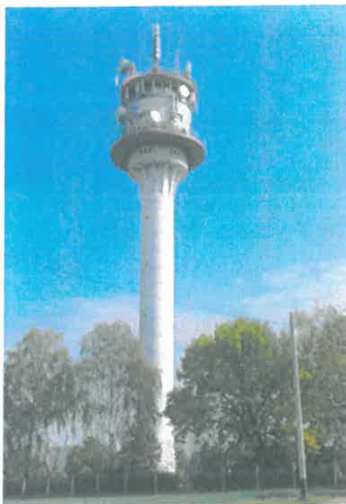
Fot. 1. SLR Kalisz Chełmce – widok obiektu
