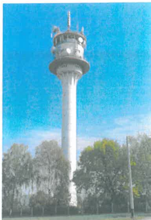
Fot. 1. SLR Kalisz Chełmce – widok obiektu
