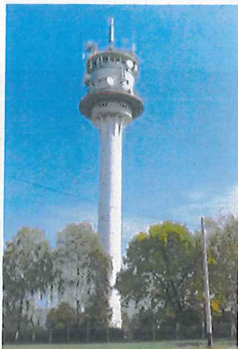
Fot. 1. SLR Kalisz Chelmce – widok obiektu
