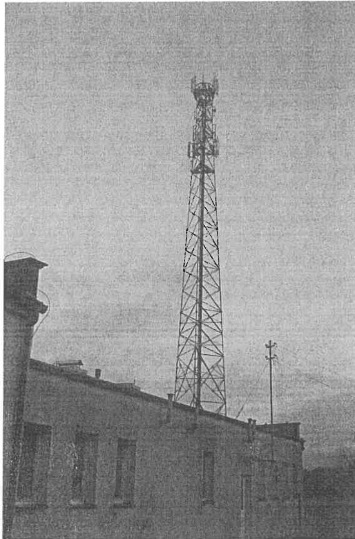
Zał. nr 1: Widok ogólny instalacji radiokomunikacyjnej.
