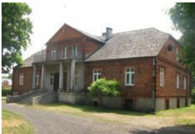
Dwór w Chodybkach – elewacja frontowa, płn.
